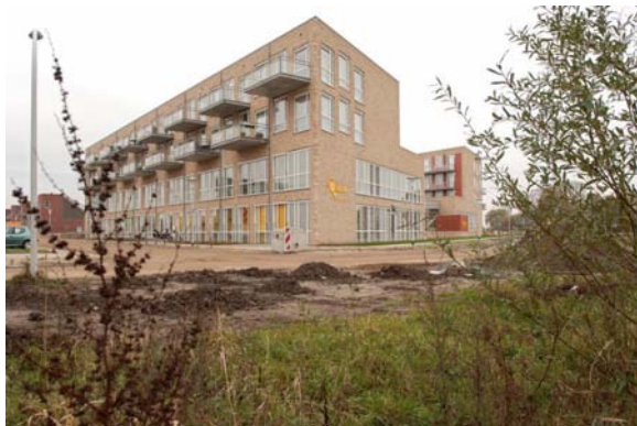
Zijaanzicht van het gebouw
