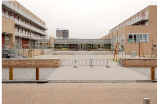
De voorzijde van het gebouw, op de voorgrond het schoolplein
