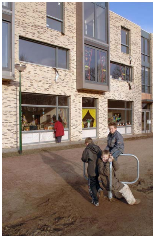
De school is al in gebruik genomen, terwijl er voor de andere gebouwdelen nog bouwwerkzaamheden plaatsvinden.
