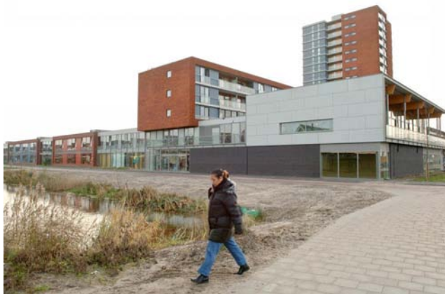
Aan de achterzijde grenst het gebouw aan water
